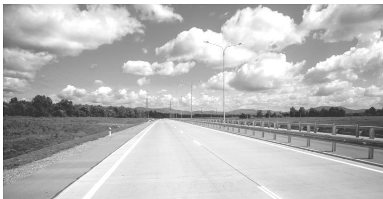
Рис. 3. Участок трассы в обход города Артема с цементобетонным покрытием
