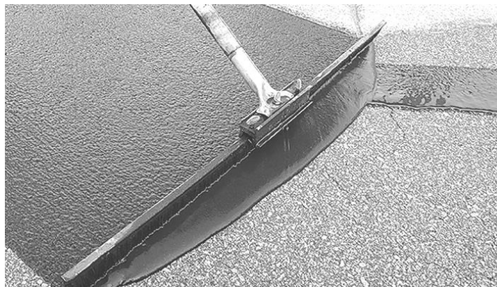
Рис.1. Нанесение пропиточного состава вручную резиновым шпателем
