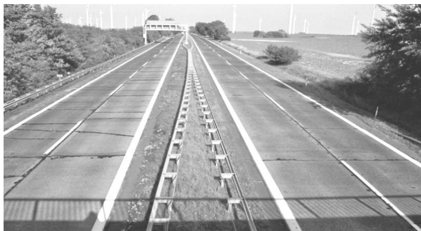
Рис. 2. Автобан Берлин-Штеттин с оригинальным цементобетонным покрытием, 2010 г.
