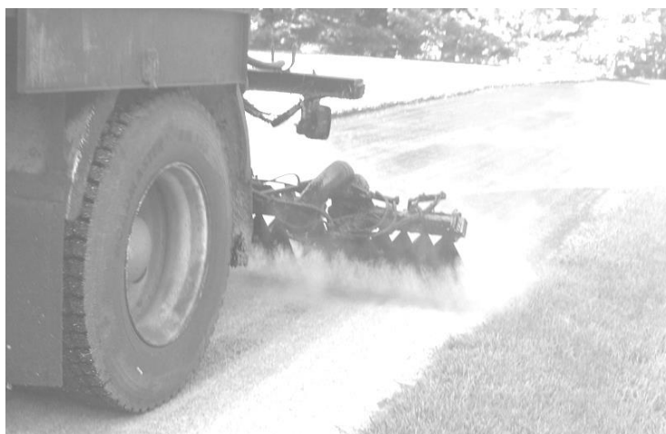
Рис. 2. Нанесение пропиточного состава машинным способом
