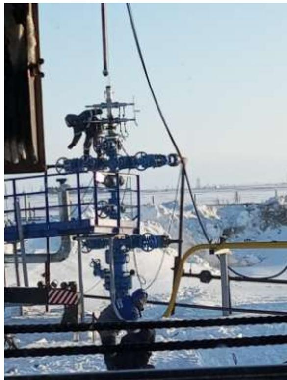
Рис. 2 – Концентрическая лифтовая колонна на устье скважины №01423 Ямбургского НГКМ (волонжинские отложения)
