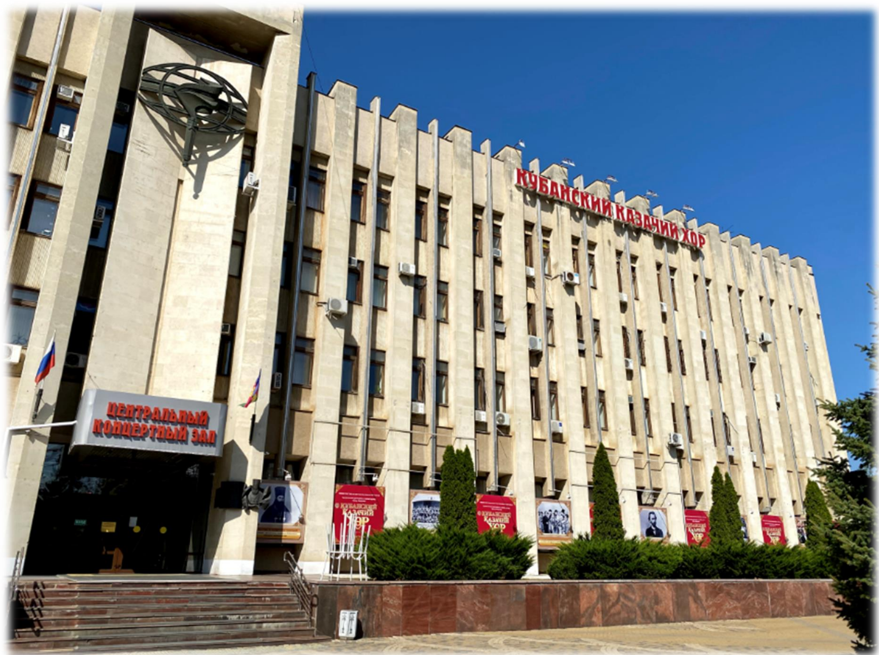
Здание Центрального концертного зала (Кубанский казачий хор)
