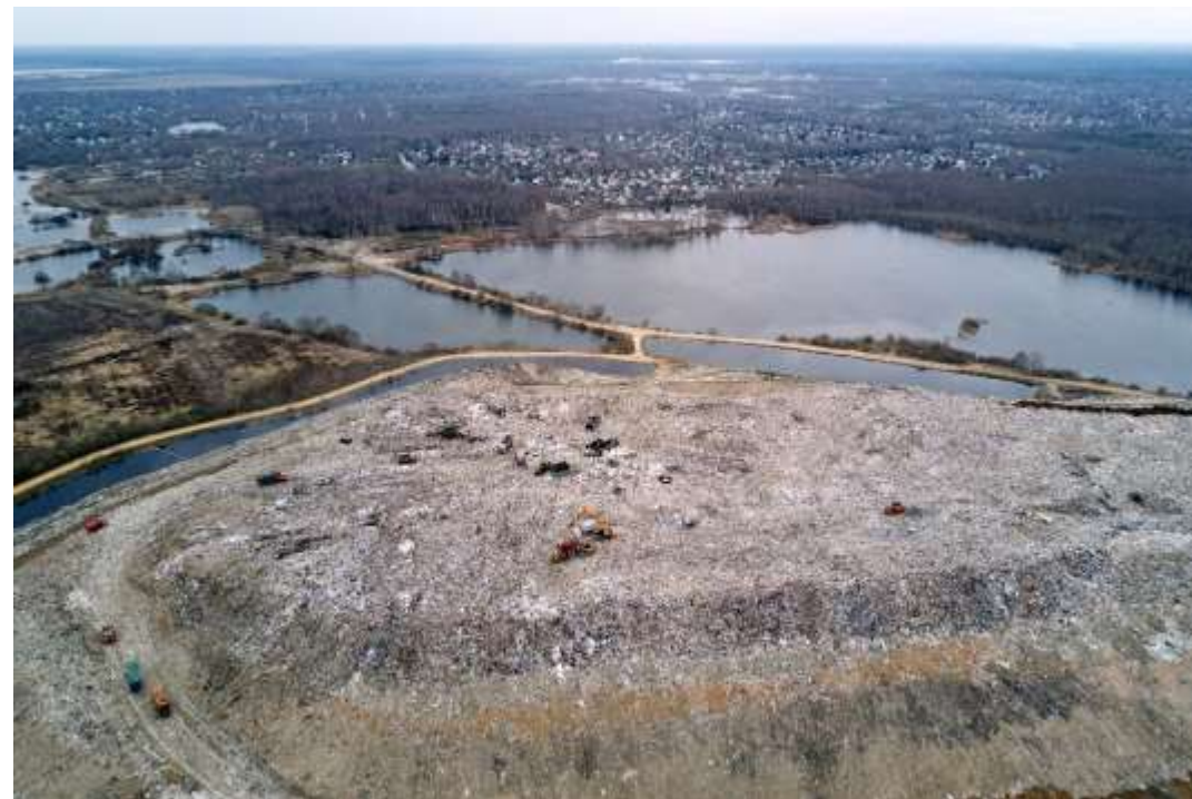
Полигон Тимохово (частичная рекультивация)
