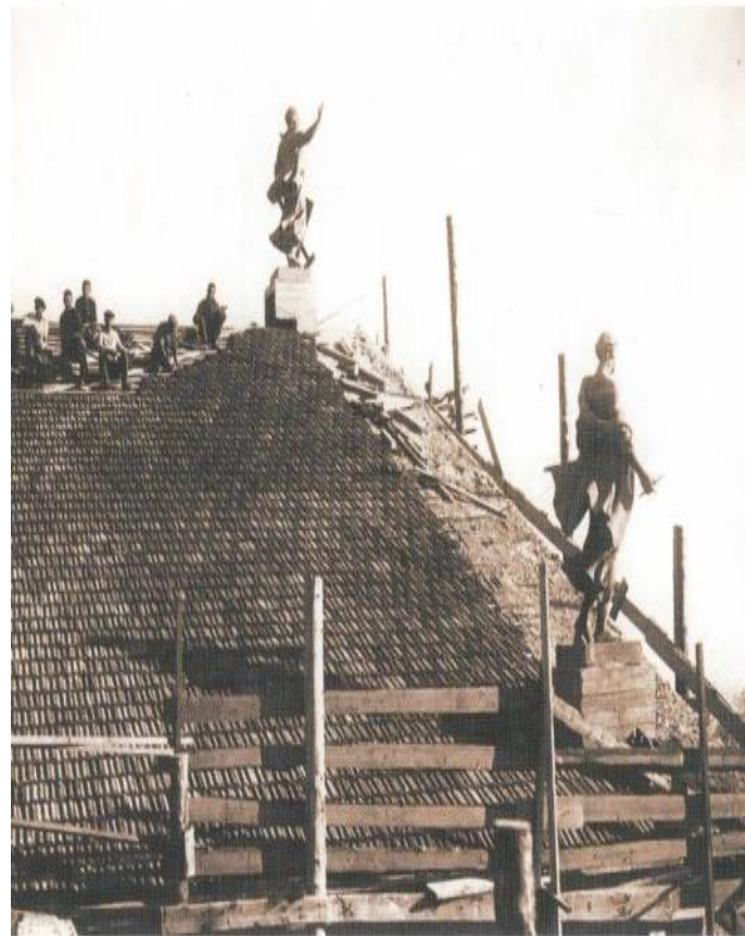
Завершение кровельных работ (1937)
