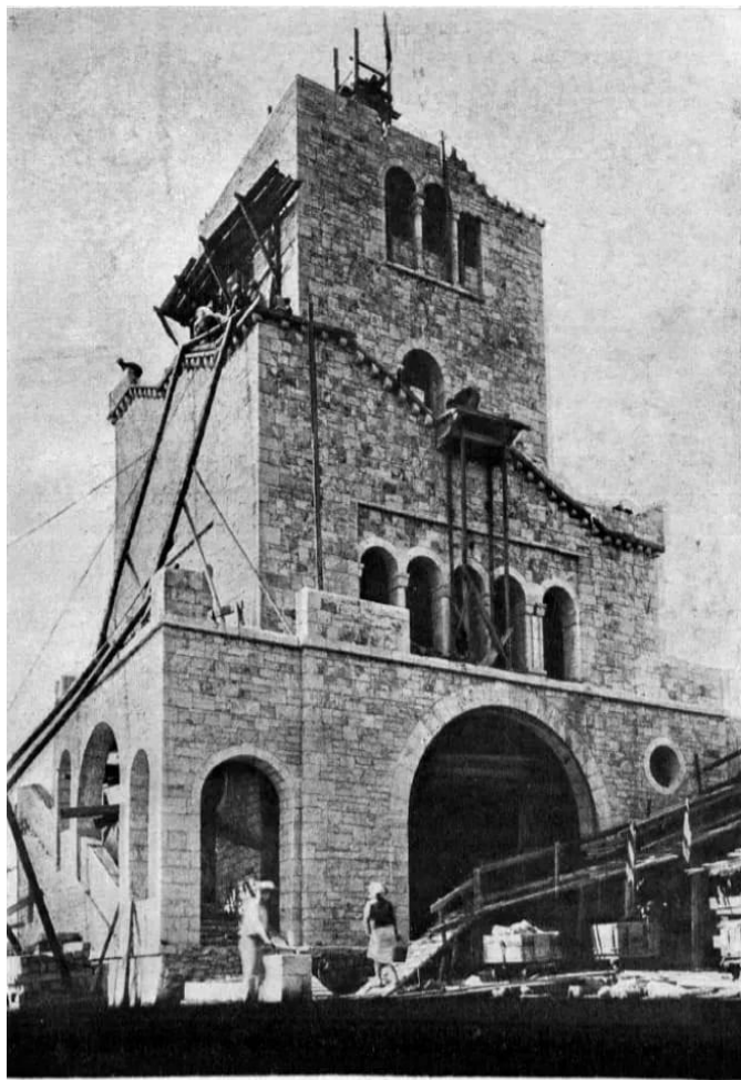
Строительство видовой башни на вершине горы Большой Охун.
